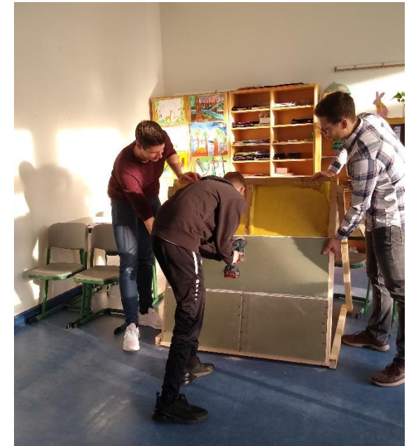
Melvin schraubt eine Rigipsplatte an
